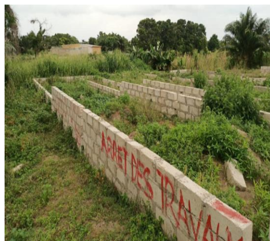
Photo 4 : des constructions en cours dans le bas-fond du quartier Tielekro, Zana 2023
