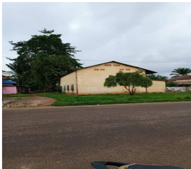
Photo 1 : Ex maison commerciale (CFCI) au quartier commerce
