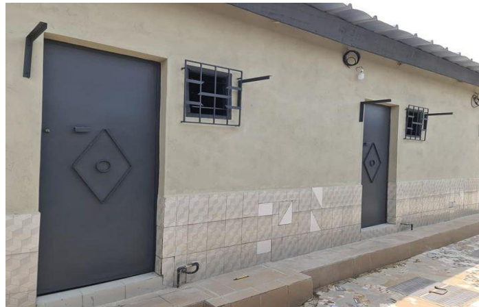
Photo 3 : Exemple d'une maison simple construite à la SOGEFHIA
