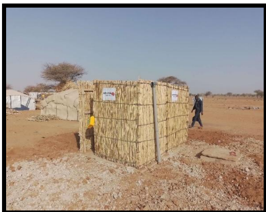
Photo 1 : Une latrine d'urgence sur le site
