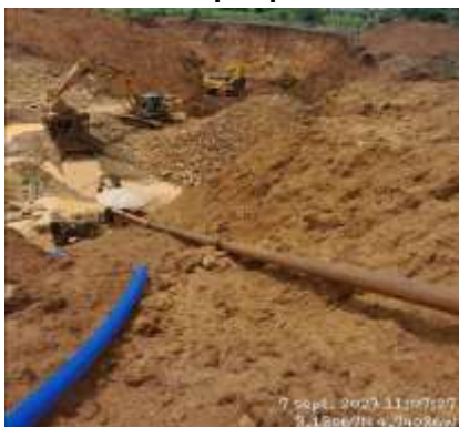
Photo 8 : Enlèvement d'eau de la fosse par la motopompe
