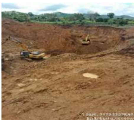
Photo 4 : Ouverture des fosses sur le site
