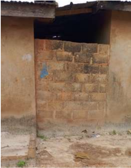
Photo 3 : Un mur construit entre deux lots à Odiennékourani
