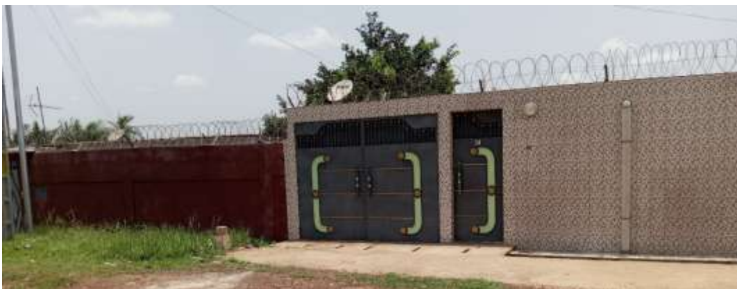
Photo 5 : Deux villas jumelées sans couloir au quartier Afridoukou résidentiel
