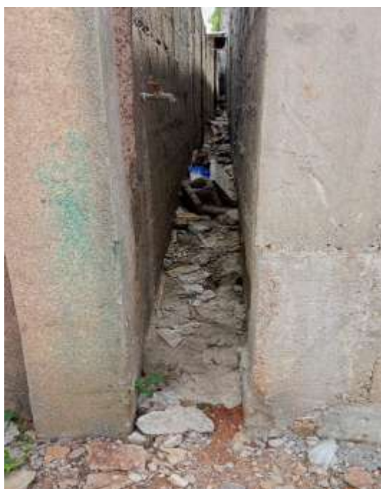
Photo 1 : Espacement restreint entre deux maisons à Afridougou résidentiel
